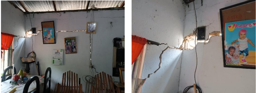
Fotografía 2. Se observan grietas estructurales de gran tamaño que atraviesan horizontalmente el muro principal, indicando una separación significativa entre bloques o entre muros y cubierta. Las fisuras comprometen la estabilidad del cerramiento. También se evidencian fracturas verticales en las esquinas y cerca de las ventanas, lo que refuerza la hipótesis de movimientos diferenciales del terreno o fallas en la cimentación. La estructura del techo, compuesta por láminas metálicas, presenta deterioro por oxidación y posibles filtraciones.
