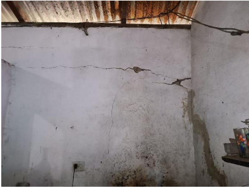
Fotografía 4. Pared interior de la cocina, se evidencian múltiples grietas horizontales, diagonales y verticales que atraviesan el muro, indicando un deterioro estructural considerable. Se observan manchas pronunciadas de humedad ascendente en la parte baja, así como filtraciones cercanas a la esquina que han provocado desprendimiento parcial del revoque. El techo de lámina presenta signos de corrosión, lo que sugiere filtraciones desde la cubierta que agravan la afectación del muro.
