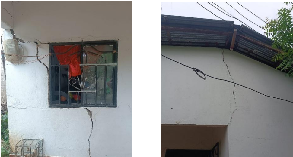
Fotografía 3. Se evidencian grietas estructurales de gran tamaño que afectan de manera crítica la estabilidad de las paredes. Además, se aprecia una fisura vertical que se extiende desde la cubierta hacia el muro frontal. Este tipo de daño puede comprometer la unión entre los elementos de la estructura y sugiere un debilitamiento progresivo de los materiales.
