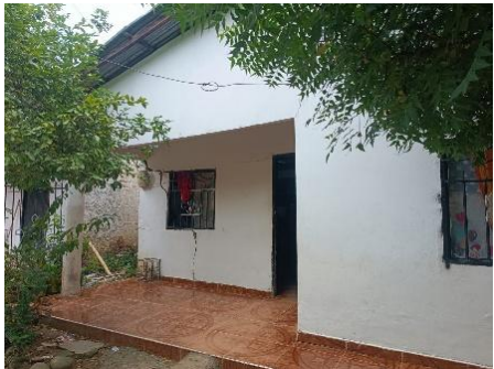
Fotografía 1. Fachada principal de la vivienda, se evidencian fisuras visibles en los muros, especialmente en la zona inferior de la ventana izquierda. Aunque el revoque presenta un acabado reciente, ya se observan señales de deterioro. El piso exterior, recubierto con losas cerámicas, muestra desniveles y posibles filtraciones.
